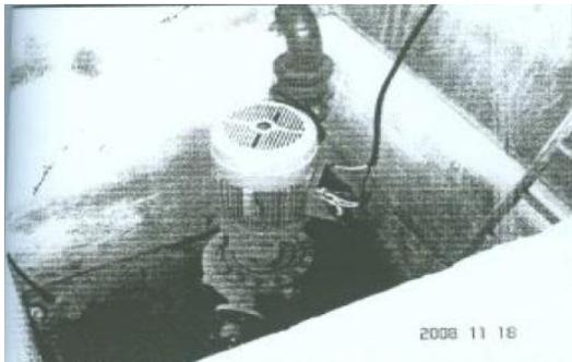
Gambar 2. Pemasangan pompa uji dengan sisi isap positif
