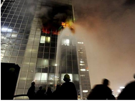
Gambar 2. Kebakaran pada Gedung
