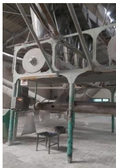
Gambar 12. Proses pemanasan oven boiler
